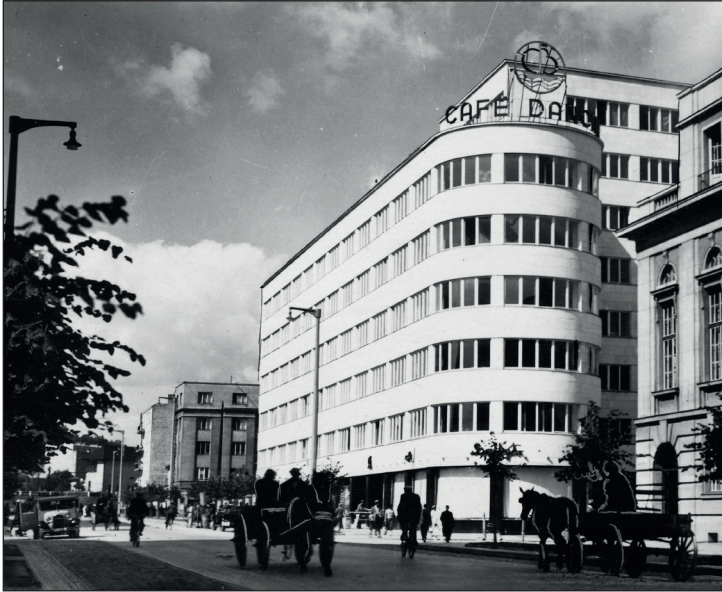
Zdj. 3. Budynek ZUS w Gdyni przy ul. 10 Lutego 24 – na ostatnim piętrze mieściła się siedziba PO.
